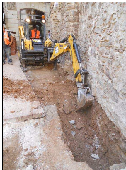
Treballs mecànics de rebaix al Sector 300
